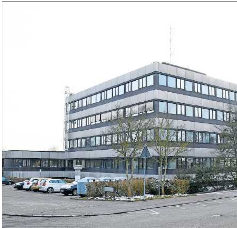
Womöglich bleiben bei einer Sanierung von der jetzigen Kreisverwaltung nur der Büroturm und das links dahinterliegende Gesundheitsamt erhalten. Fehlende Büroräume müssten dann angemietet werden. FOTO: BUCHHOLZ
